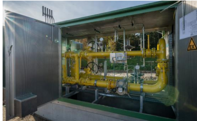
Gasdruckregelanlagen
